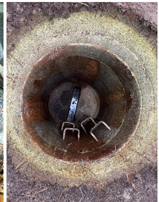
Figur 15. Her er et billede af en brønd som ser fin og ren ud og kræver ikke spuling
