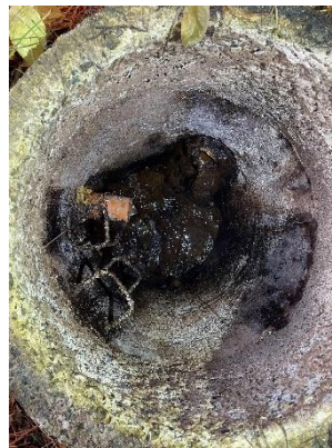
Figur 1. Her er et billede af en brønd der tydelig trænger til at blive spulet
