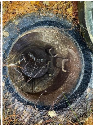
Figur 2. Her er et billede af en brønd hvor der er en lille smule aflejringer i bunden, men ikke nok til at den behøves spulet og kan vente til næste gang
